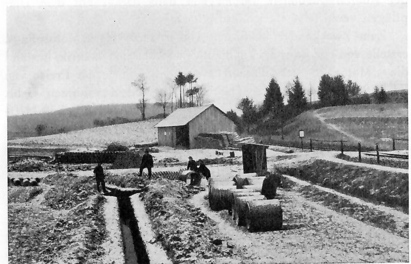
Lager von Drainage-Röhren.
